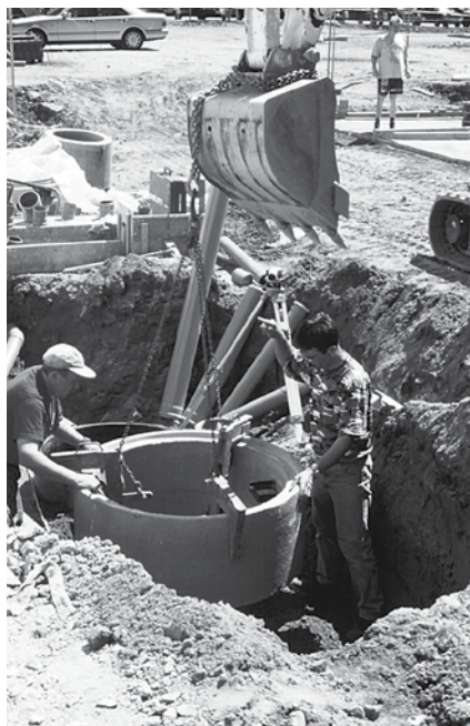
LIPUMAX® vasbeton helyére emelése darus függesztéssel
