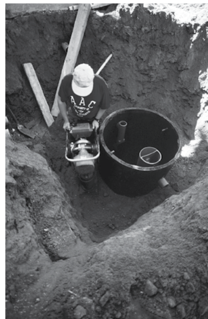
Réteges földvisszatöltés réteges tömörítés mellett
