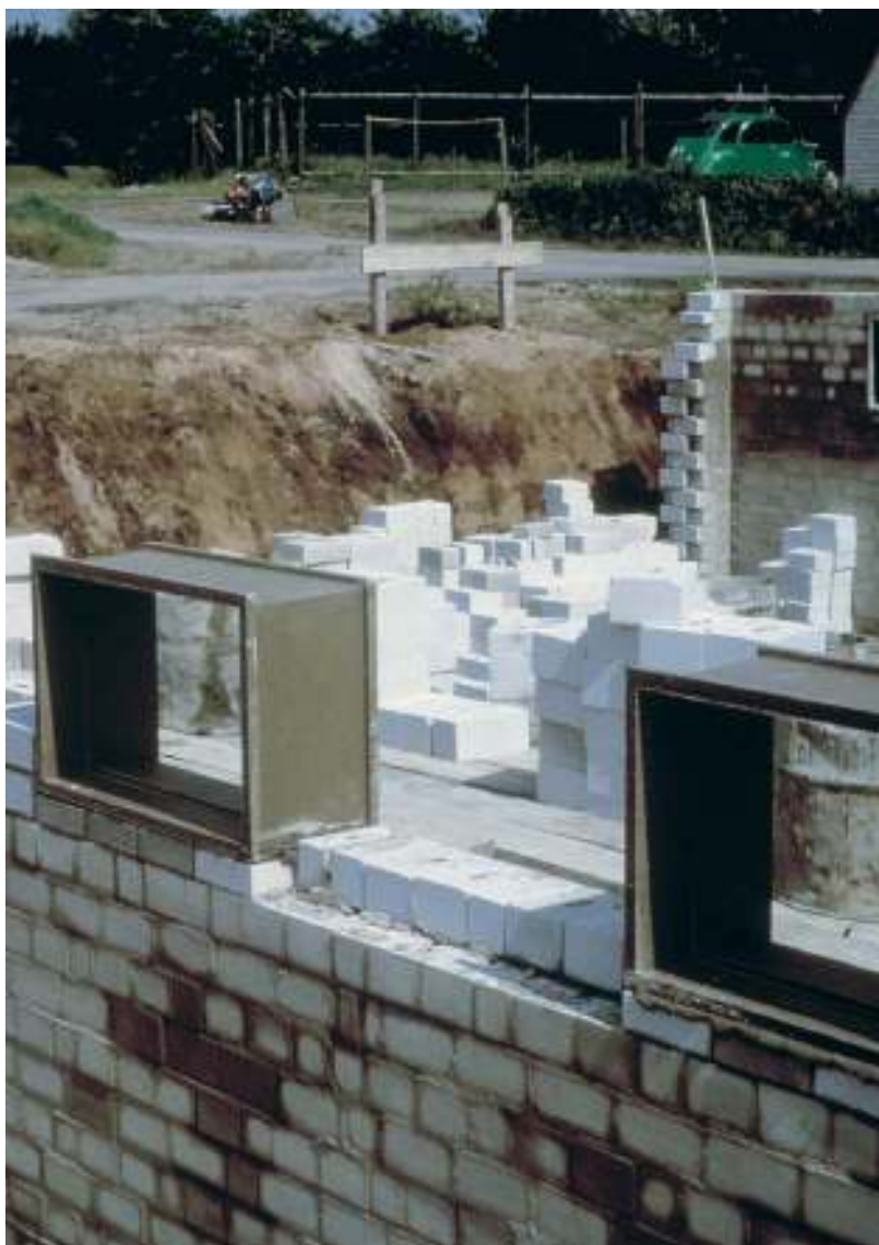
Ablakkeret beépítése falazott fal esetén
