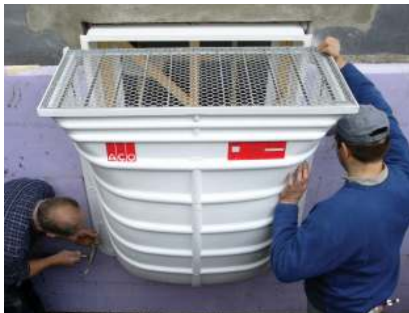
ACO Világítóakna polipropilénből, merevítő bordázattal
