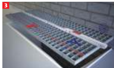
3 Felezze meg a rács szélességét (x tengely), majd a mélységét (y tengely) és adja hozzá a faltól való távolságot a mélységhez. Anschließend können Sie die vier Profilstücke zusägen und den Rahmen zusammenstecken
