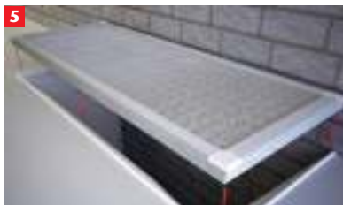
5 Rögzítse a fedelet a rácsra. Végül szerelje vissza a rácsot, mint ahogy az aknára szerelte. Kész az ACO avar-és rovarvédelme.
