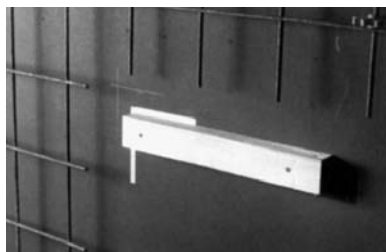
A sarok bejelölése a zsaluzaton, és a lécfeszítéssel
