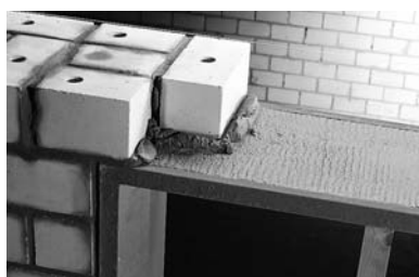
Stabil, alaktartó kötést kell létrehozni
